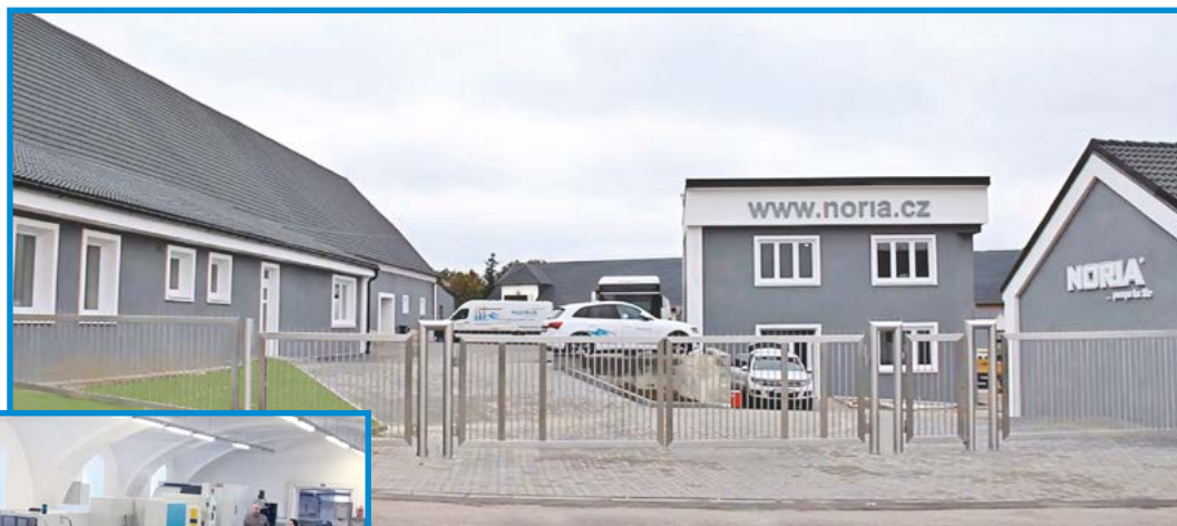
Výrobní areál společnosti NORIA v Tavíkovicích
