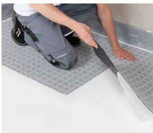
2a. Postupné přilepení rohože - deska
