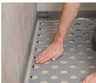
5. Přilepte část rohože na poklad
