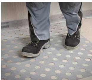
7. Na celé ploše přitlačte na podklad
