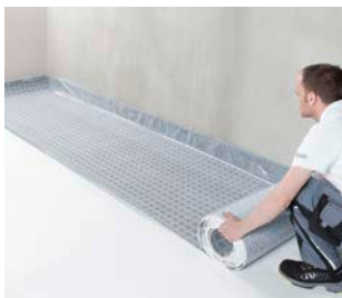
2b. Postupné přilepení rohože - role
