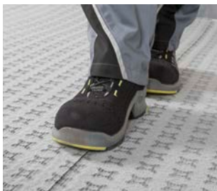
4. Přitlačte pevně přesahy rohože
