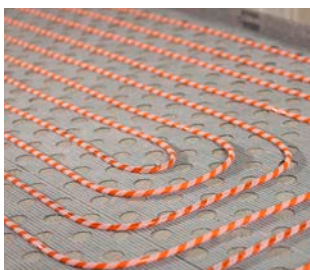
11. Hotová pokládka, proveďte tlakovou zkoušku
