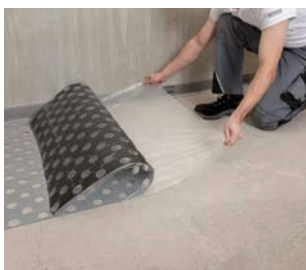
6. Odstraňte zbytek ochranné folie
