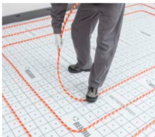
6b. Pokládka trubky RAUTHERM SPEED K
