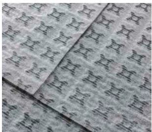
5. Položte rohože tak, aby vytvořily „T-spoj“
