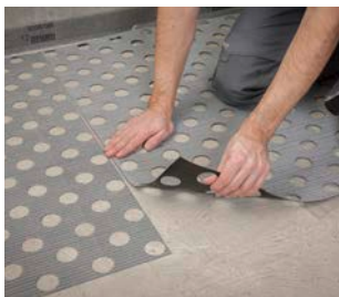
8. Další rohož přilepte bez překrytí
