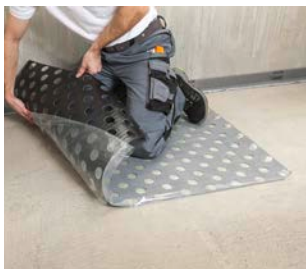
4. Ze spodní části odlepte ochranou folii
