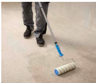
1. Natření podkladu vhodnou penetrací
