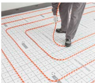
6c. Pokládka trubky RAUTHERM SPEED K
