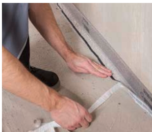
3. Přilepení folie patky dilatační pásky
