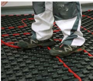
3. Pokládka trubky RAUTHERM S
