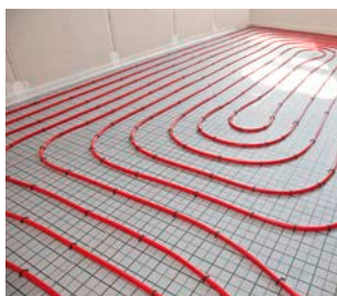
6. Hotová pokládka podlahového vytápění
