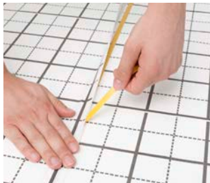
2. Slepění přesahů pokládací desky Tacker
