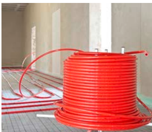
3. Pokládka trubky z odvíjecího zařízení
