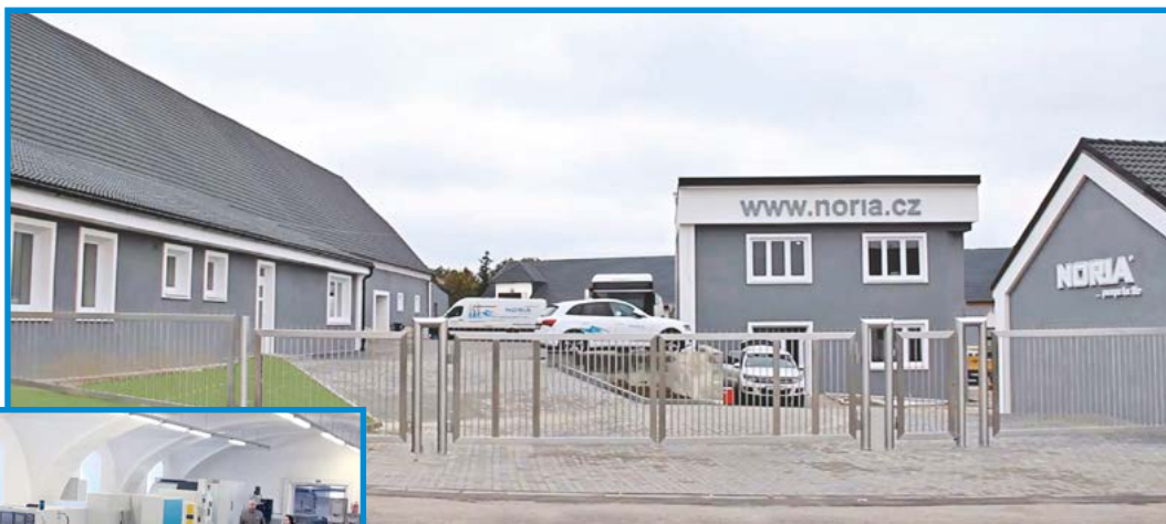
Výrobní areál společnosti NORIA v Tavíkovicích
